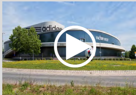
Fabrica automatizată Adidas
